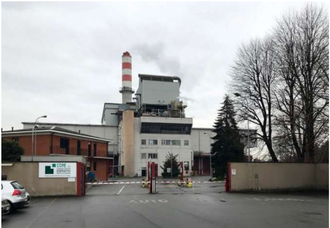
Figura b - Vista ingresso impianti CAP e CORE
