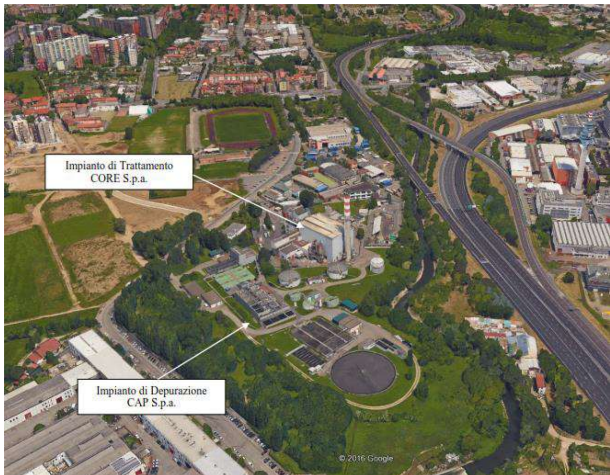
Figura a - Vista aerea degli impianti CAP e CORE.
